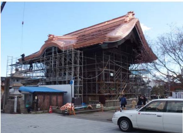
4.屋根改修後-妻側 (2020.03.11)
