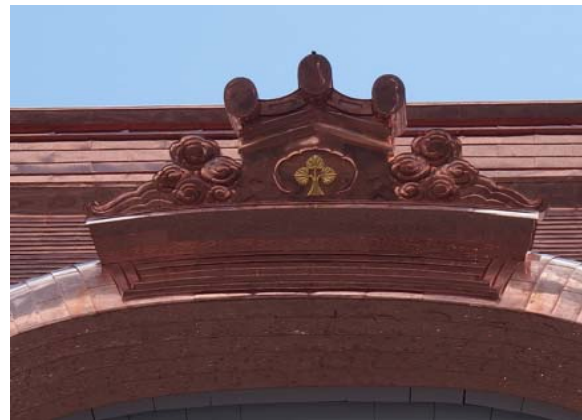
6.屋根改修後-唐破風鬼 (2020.03.11)
