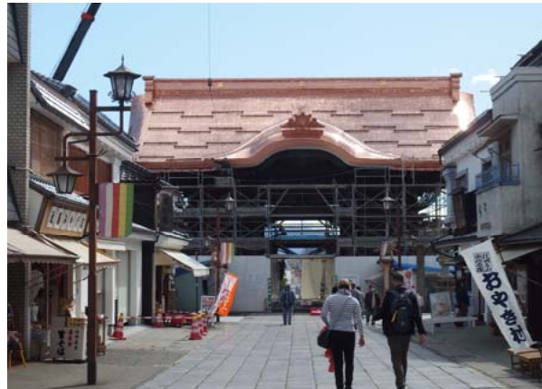
3.屋根改修後-北側 (2020.03.11)
