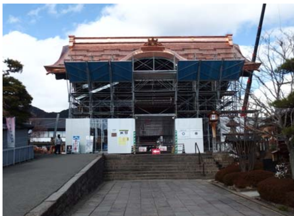
2.屋根改修後-南側 (2020.03.11)
